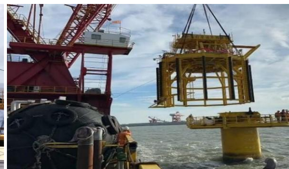
具有自主知识产权的桩基式单点系泊系统，在“乌石17-2&23-5油田群联合开发项目成功应用
