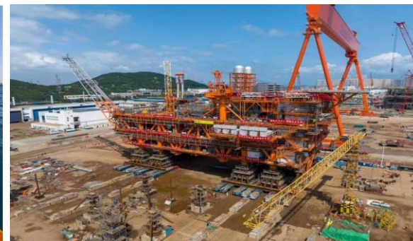
SPMT移位运输技术在惠州和涠洲组块成功实施，节省重量转移材料费并工装利旧，实现降本4348万元
