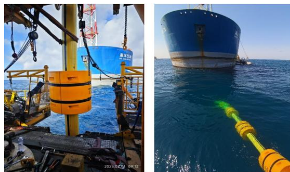
国产动态柔性立管在HYSY116 FPSO复产项目中应用，节省工期1.5年，实现降本2499万元
