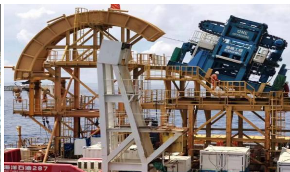
通过柔性管缆水平铺设技术及装备应用，施工效率提升20%以上，人力投入减少25%
