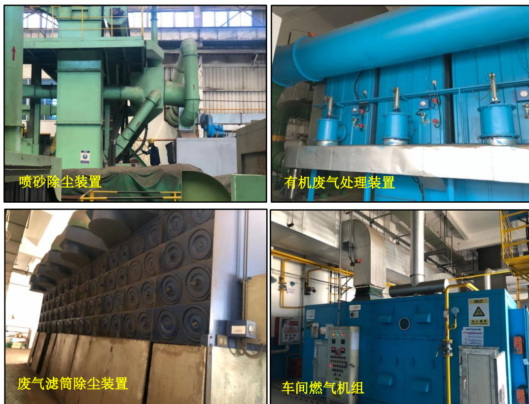
图 2.3-3 现有工程现场照片
