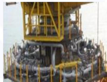
单点工艺管线连接 SPM Process Pipe Connection
