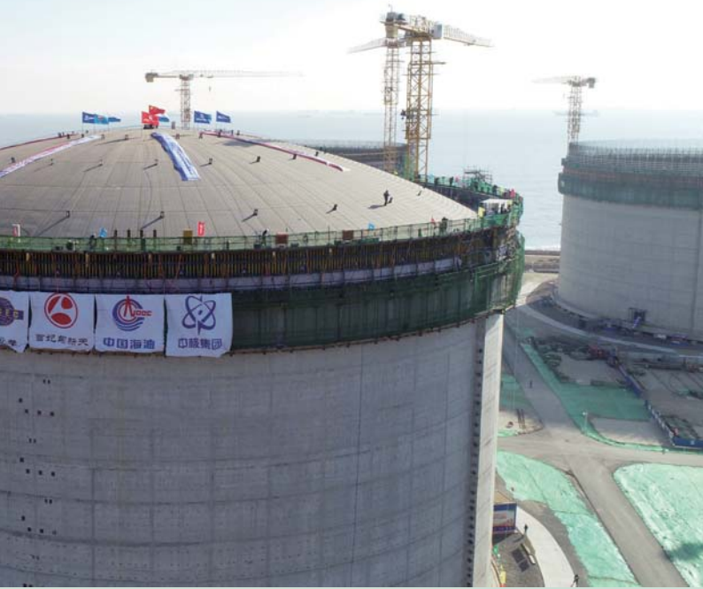
◀ Phase II works of Tangshan LNG Terminal Project
