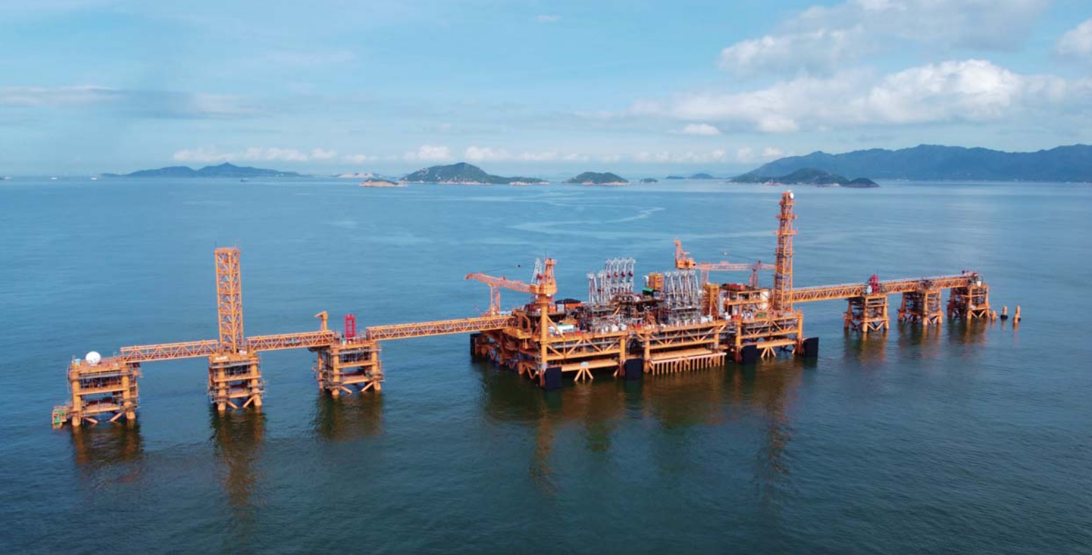
▲ Construction site of Hong Kong Offshore LNG Terminal Project
