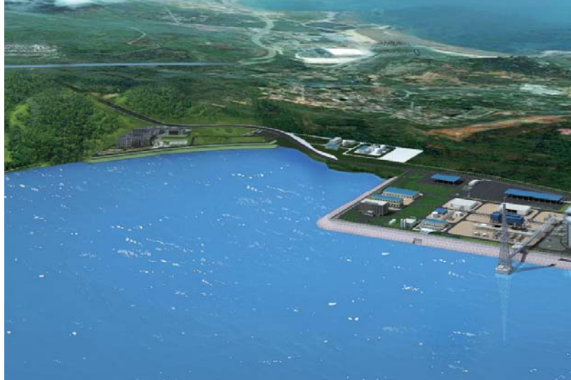
▲ Aerial view of Fujian Zhangzhou LNG Terminal Project
